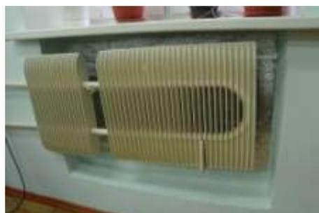
Фото 7-12. Пример установки теплоотражающего экрана.
