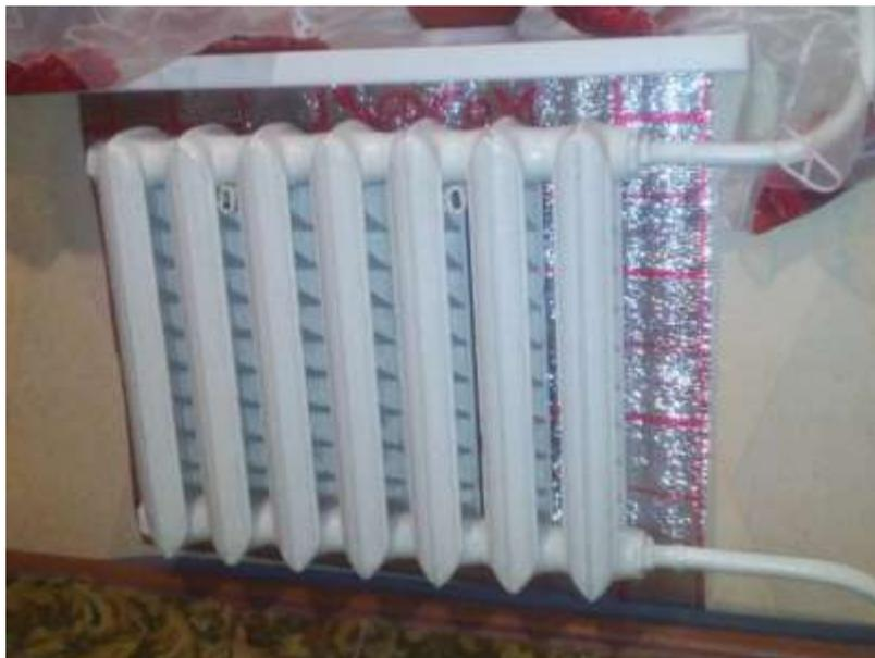
Фото 15. Установка теплоотражателя в домашних условиях.
